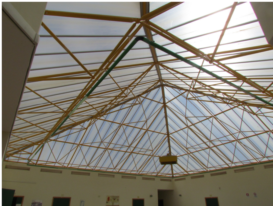
Foto 3 - vista interna struttura reticolare in acciaio
