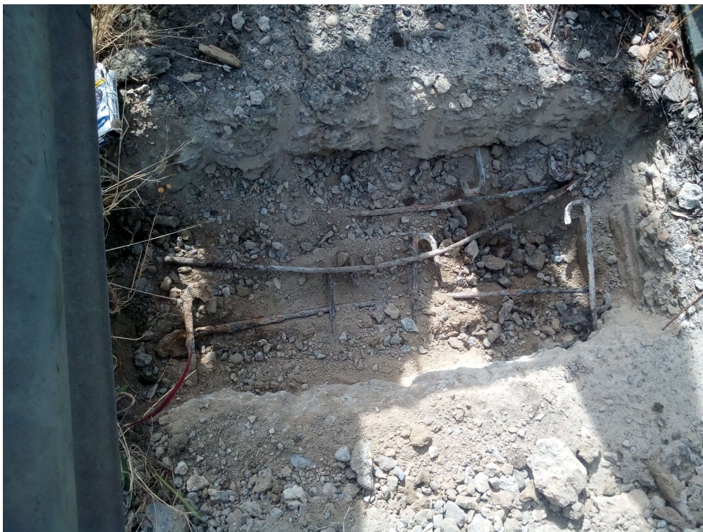
Figura 7. Saggio effettuato sul cordolo stradale
