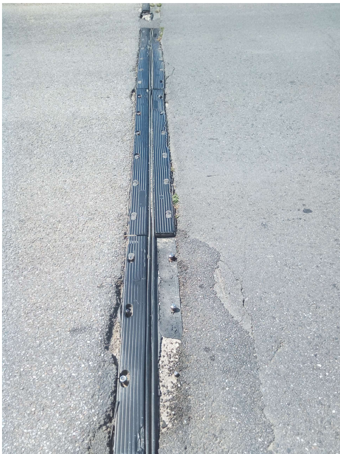
Figura 6. Giunto di dilatazione
