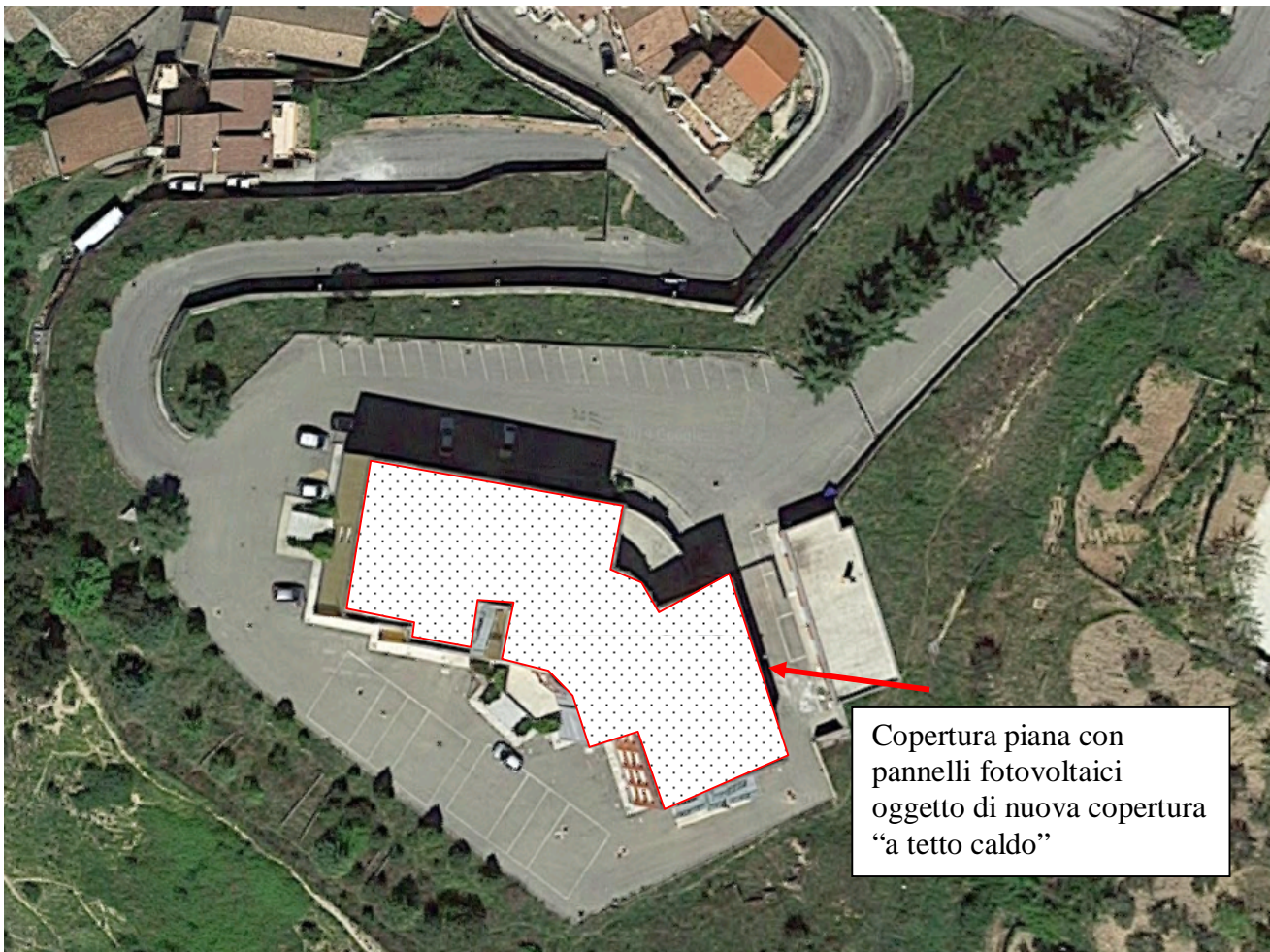
Copertura sede ITC DI ACRI oggetto di intervento
