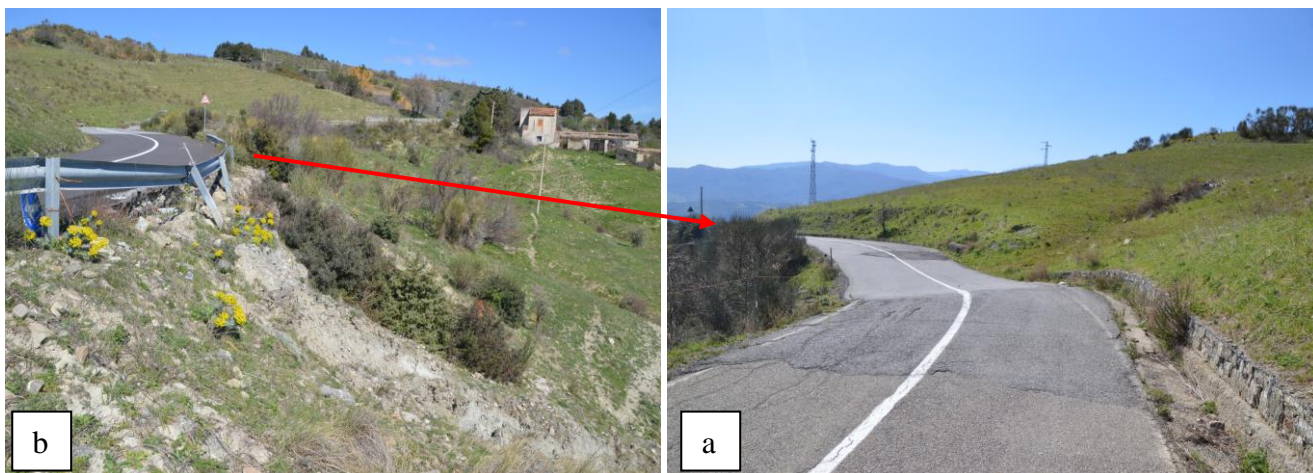
Sito 2 – a) Stralcio foto 3f da Tavola 4 (Report Fotografico); b) smottamento di sottoscampa alla curva di qt. 610 m s.l.m., che ha coinvolto parte dei gabbioni collocati in precedenti interventi
