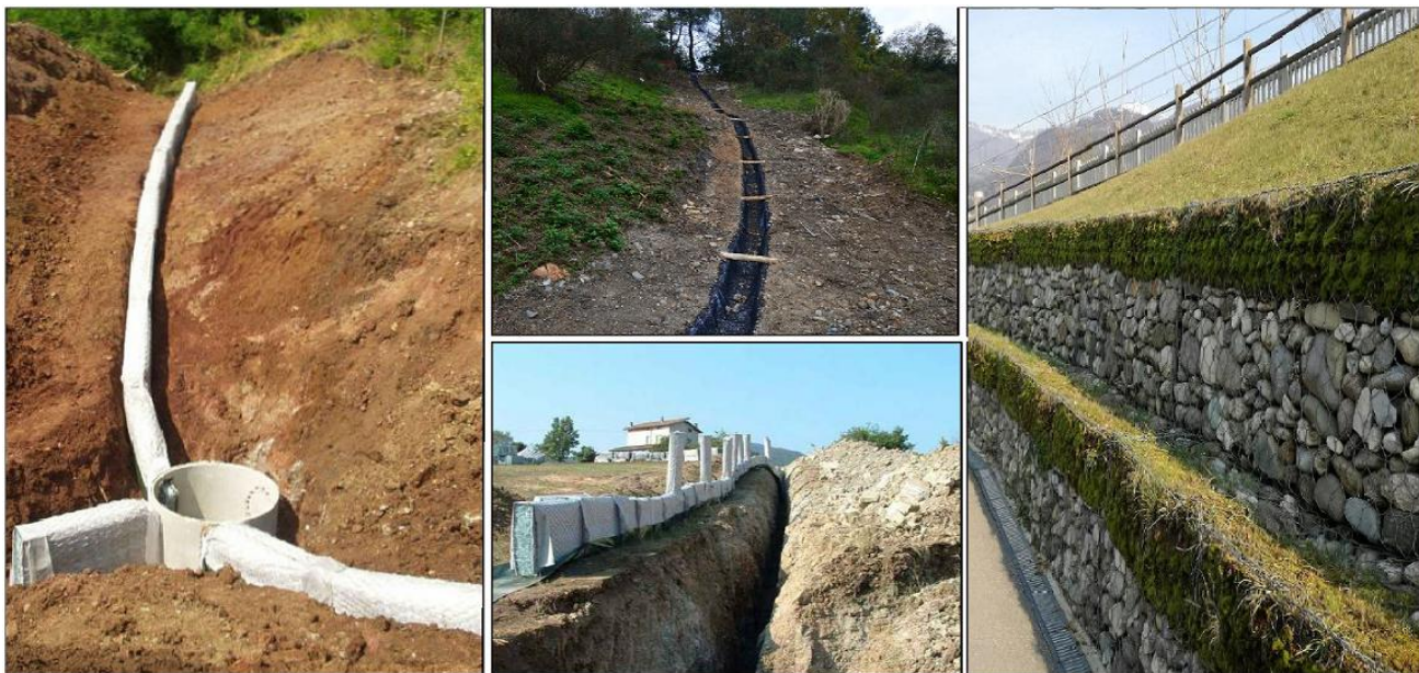
Esempi delle principali opere da realizzare per il ripristino della sede stradale della SP 147: trincee drenanti tipo Gabbiodren, muro in gabbioni rinverdibili, fosso di guardia e canali di drenaggio superficiali in Trenchmat S®
