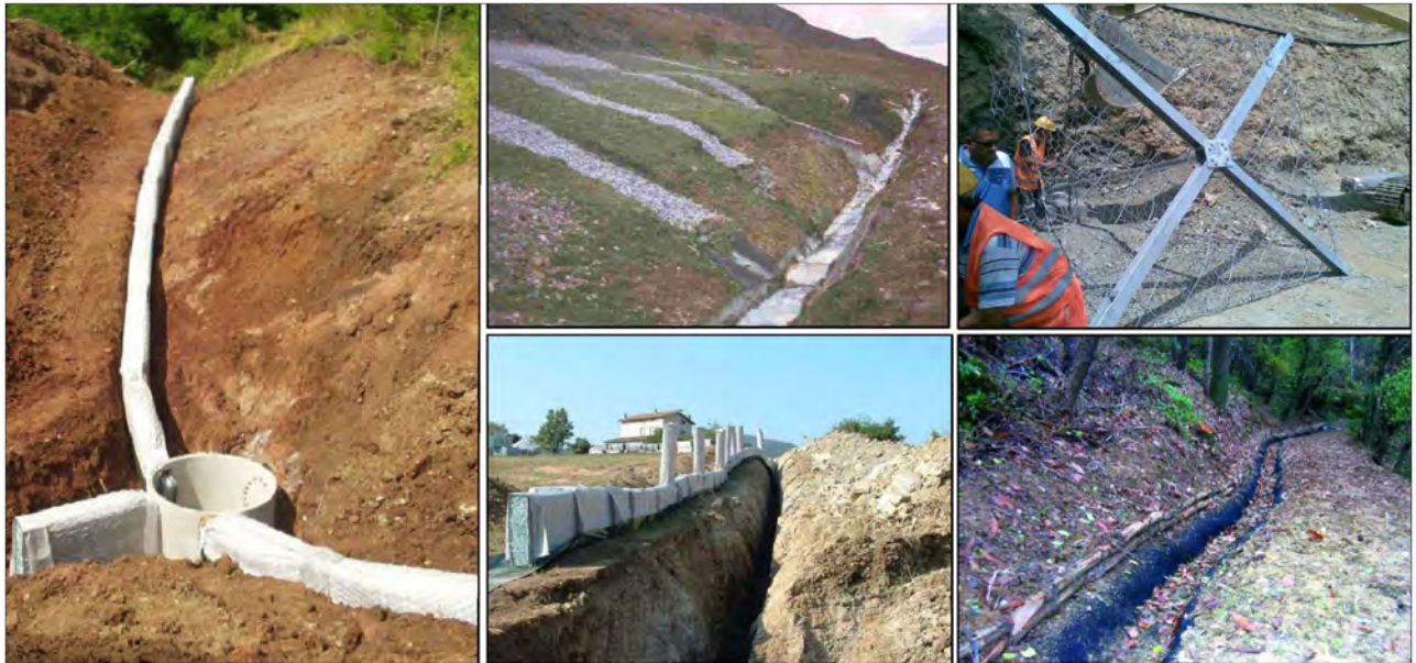
Esempi delle principali opere da realizzare per il ripristino della sede stradale della SP 147: trincee drenanti tipo Gabbiodren, muro ad "ombrelli", fosso di guardia e canali di drenaggio superficiali in Trenchmat S®
