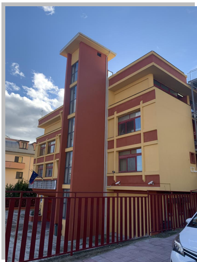
Foto 2 : Scuola IPSSAR di Castrovillari visto da corso Calabria
