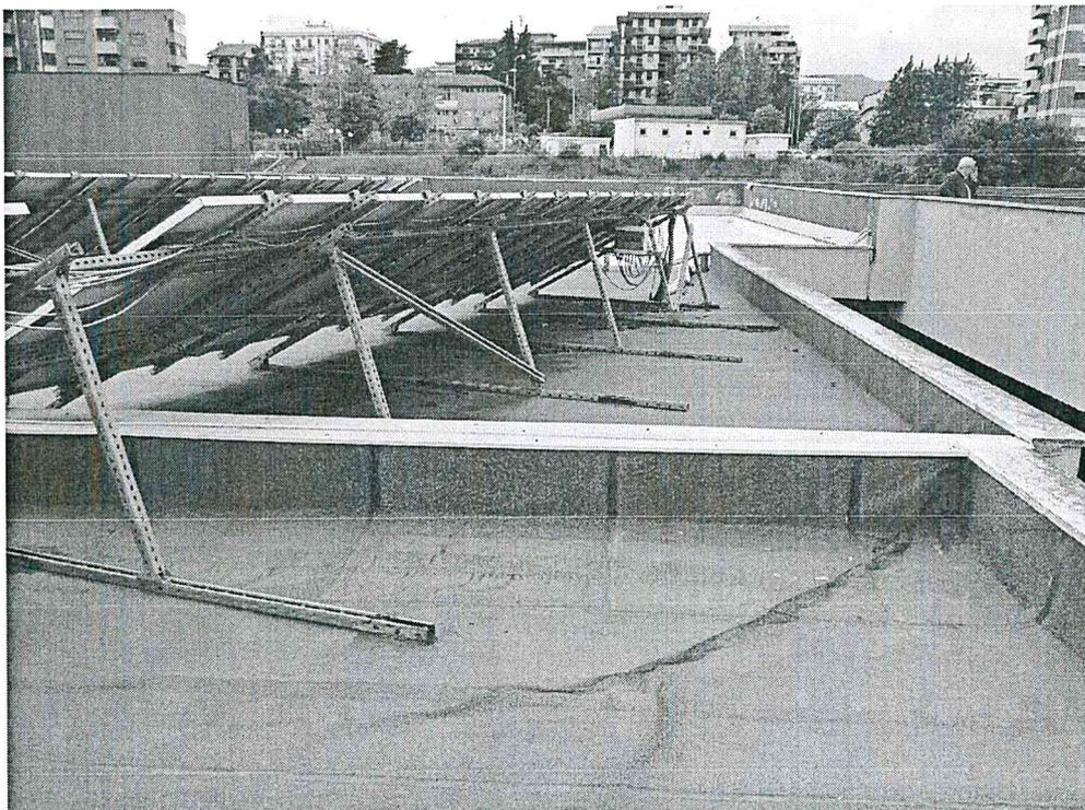
Presenza di impianto fotovoltaico da rimuovere e riposizionare su zavorre.
