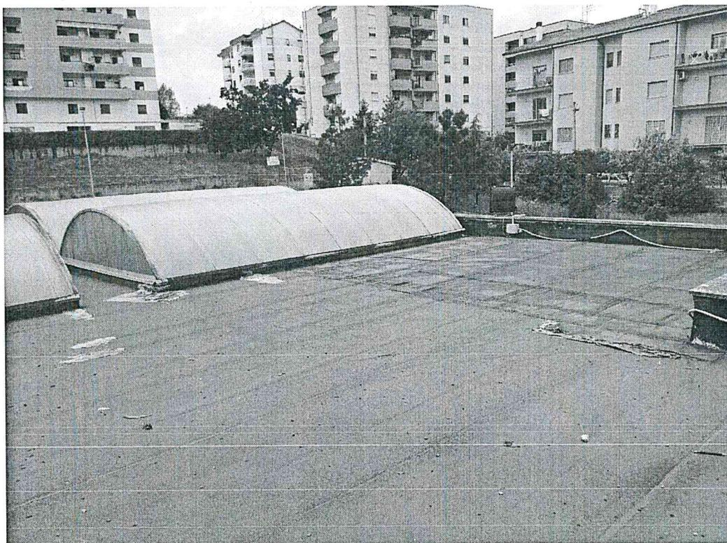
Presenza di lucernai in vecchio policarbonato da sostituire con nuovi pannelli e nuove strutture.
