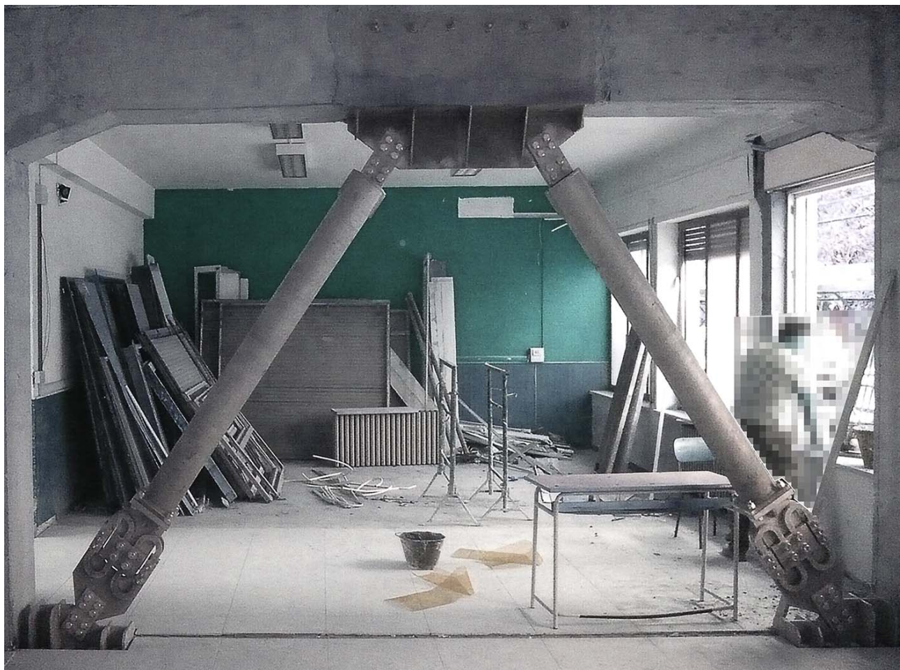
Installazione di controventi dissipativi
