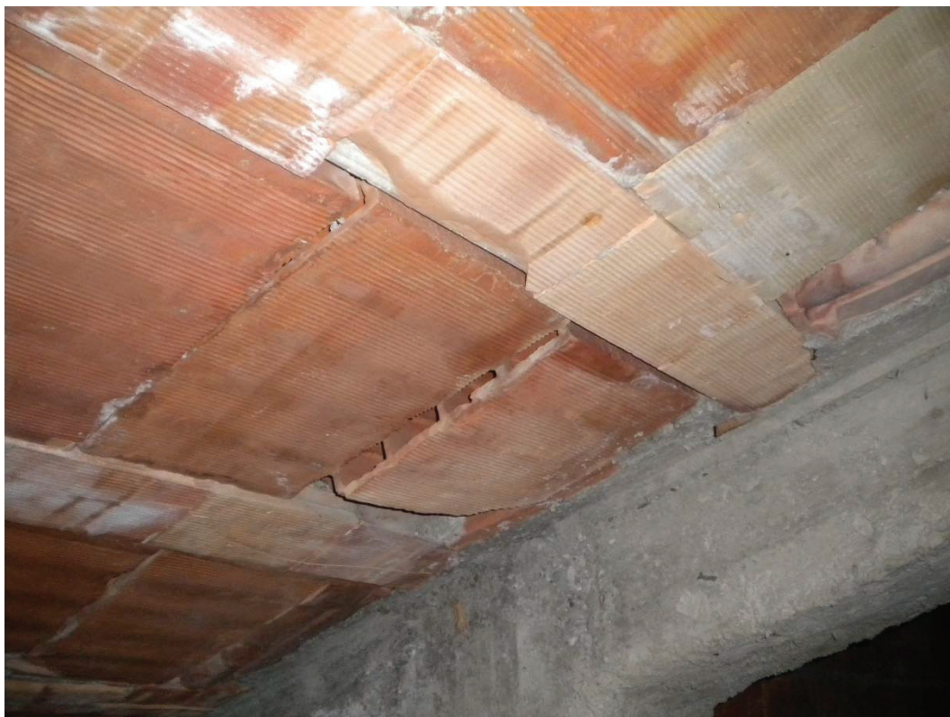
Fig. 4.10 – Particolare dello sfondellamento dei laterizi
