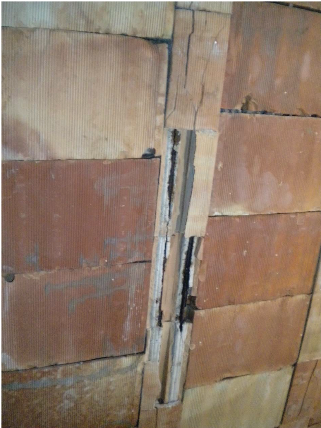
Fig. 4.12 – Particolare del degrado del solaio di copertura
