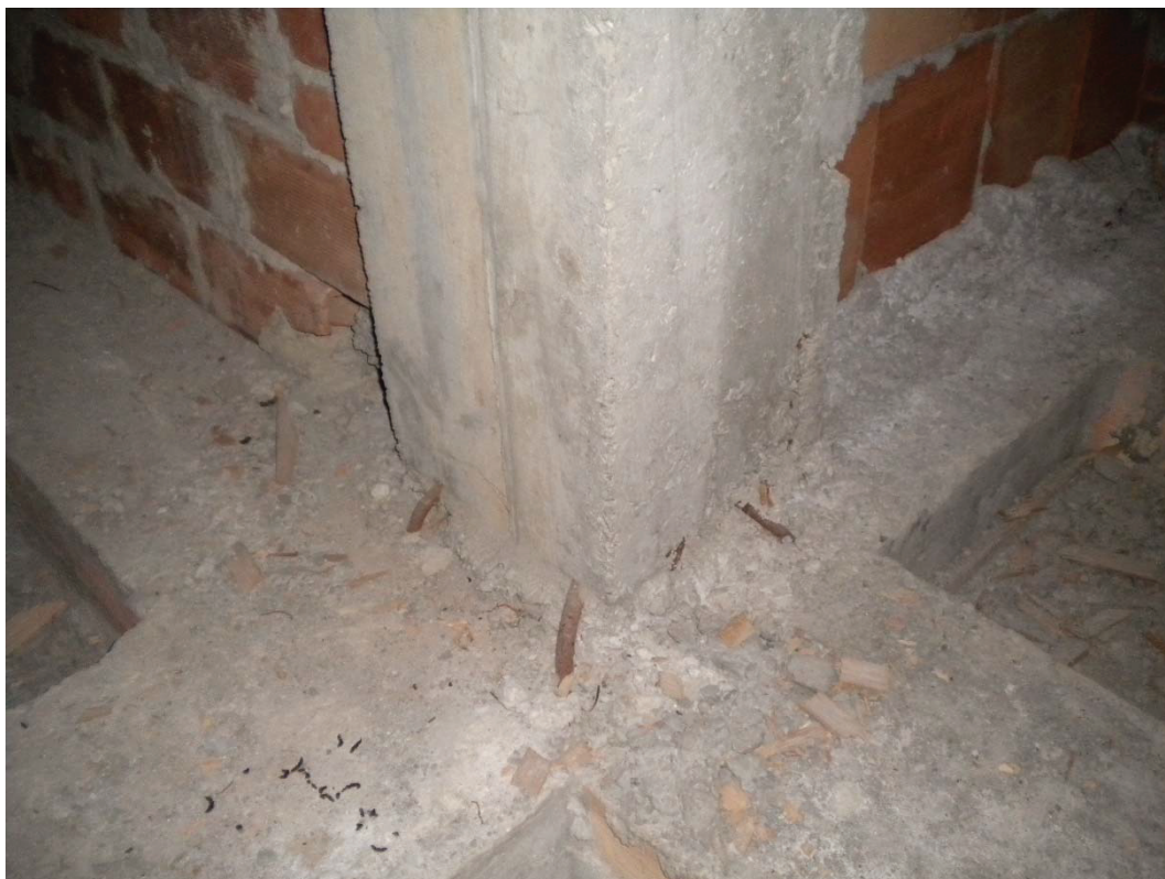
Fig. 4.13 – Particolare del degrado del solaio di copertura
