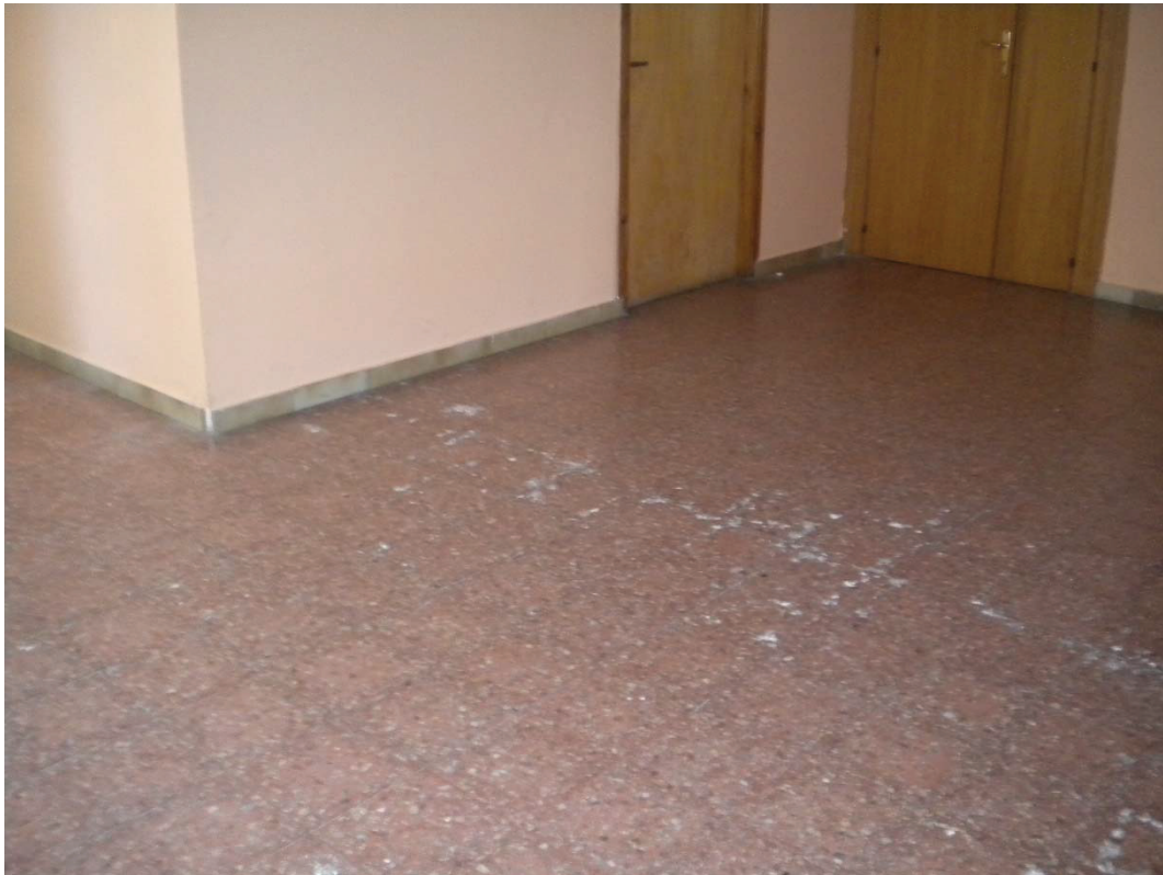
Fig. 4.6 – Degrado pavimentazione a piano terra
