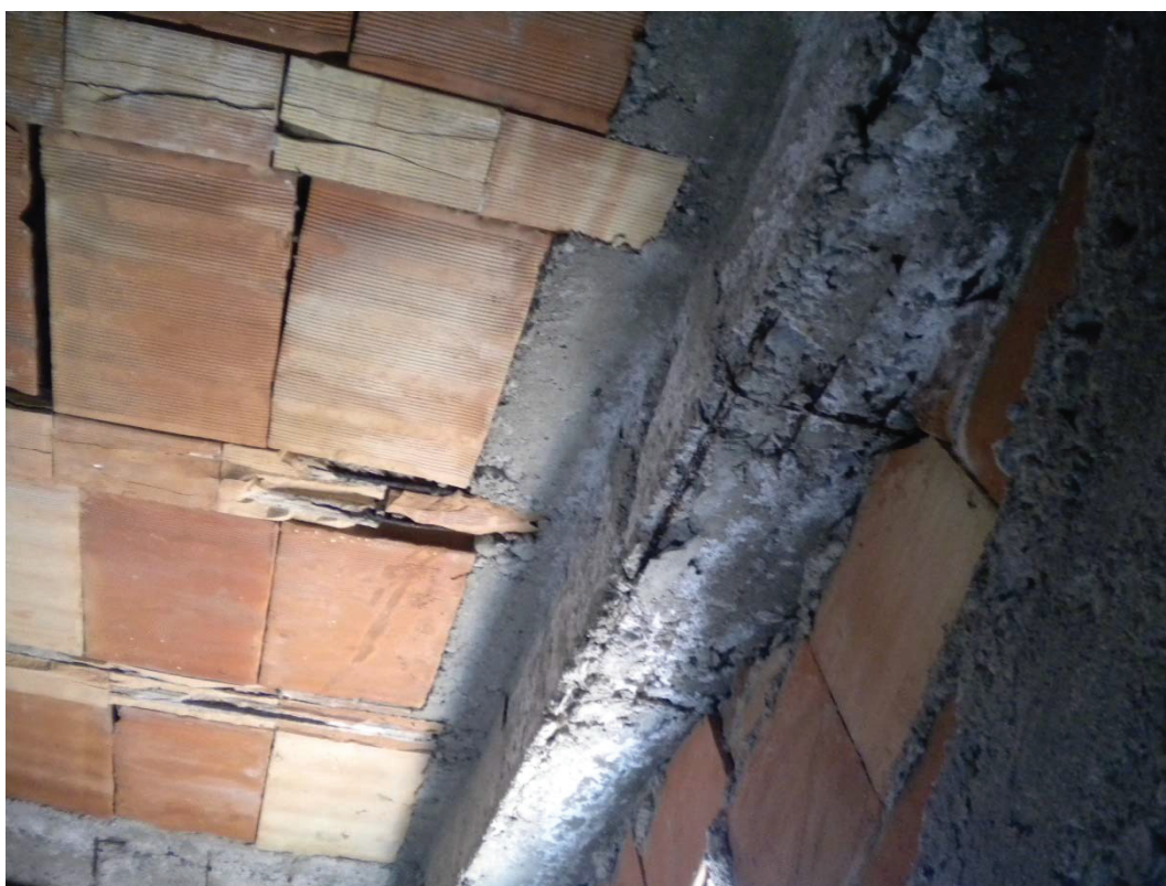
Fig. 4.11 – Particolare del degrado della struttura di copertura IPRE01 - Relazione Tecnica di Intervento
