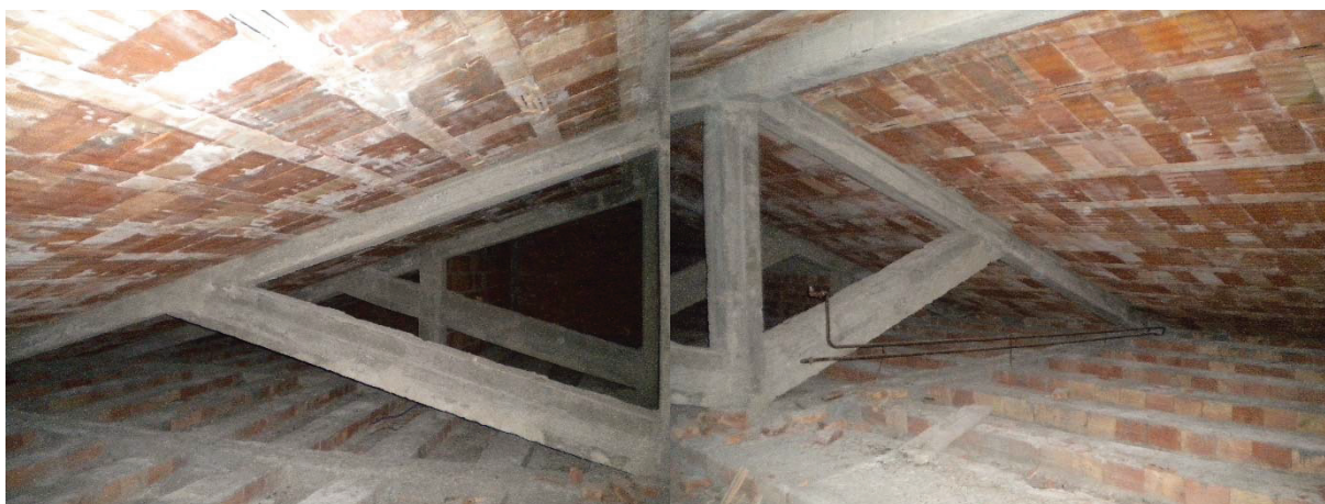
Fig. 4.9 – Struttura reticolare di sostegno della copertura
