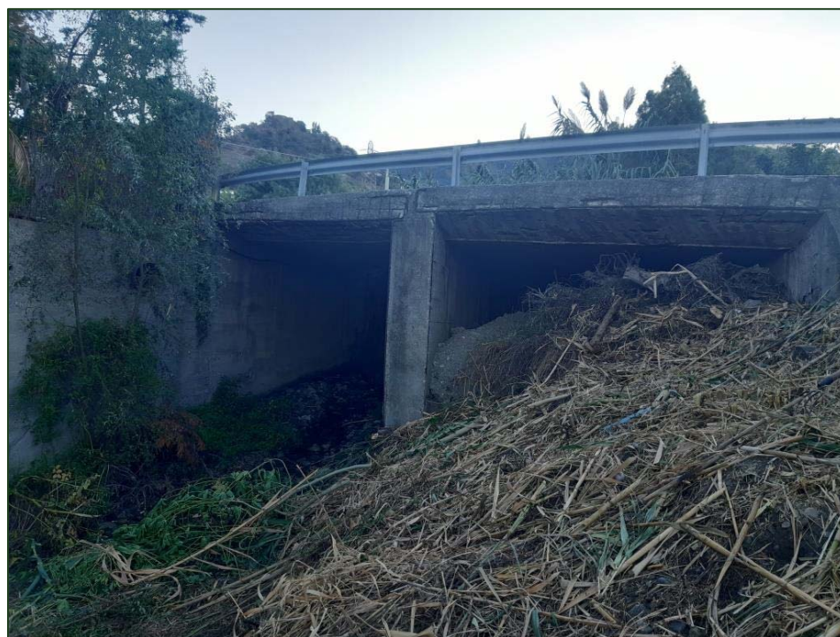
Fig. 3: Ponte S.P. 39 – Accumulo di materiali terrosi
