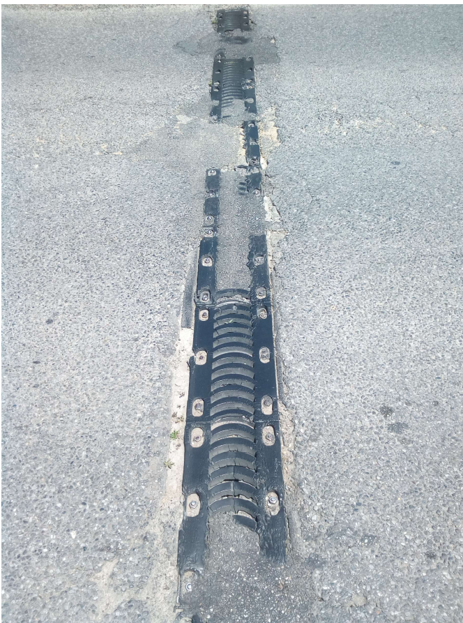
Figura 6. Giunti di dilatazione esistenti
