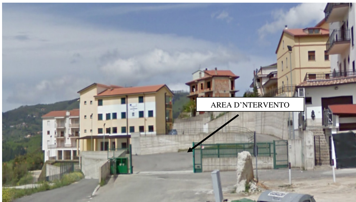
Foto 2 – area esterna d'intervento
