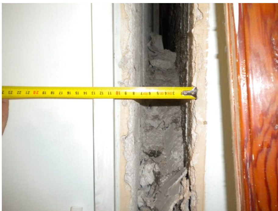
Particolare giunto tecnico esistente
